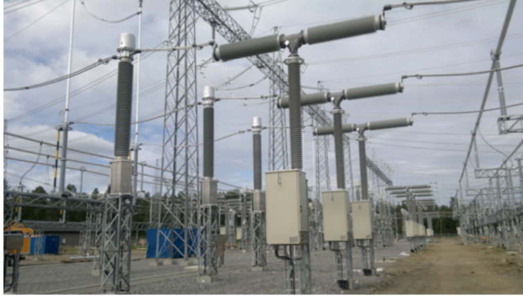
Figure 3: Combined - en kombinerad brytare och frånskiljare från ABB[2]
