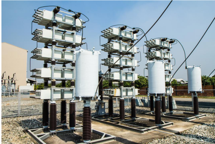
Figure 4: Kondensatorbanker för korrigering av effektfaktorn[10]
